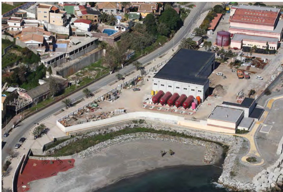
Desaladora de Ceuta
